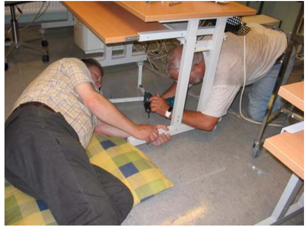
Lisäjöbi aiheutui telineiden asennuksesta Kuvassa porausryhmä Tane ja Risto
